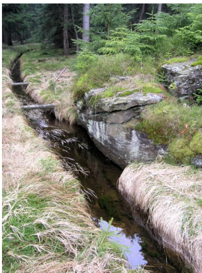
Blatenský vodní příkop mezi Bludnou a Horní Blatnou, vpravo asi jediné místo, kde byl příkop ražen i ve skále (foto: Michal Urban)
