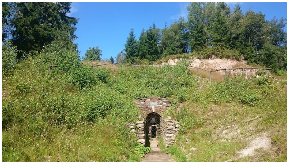
Při zpřístupňování štoly Kryštof bylo třeba odbagrovat část haldy dolu Mauritius, která počáteční úsek štoly zasypala (foto: M. Urban).
