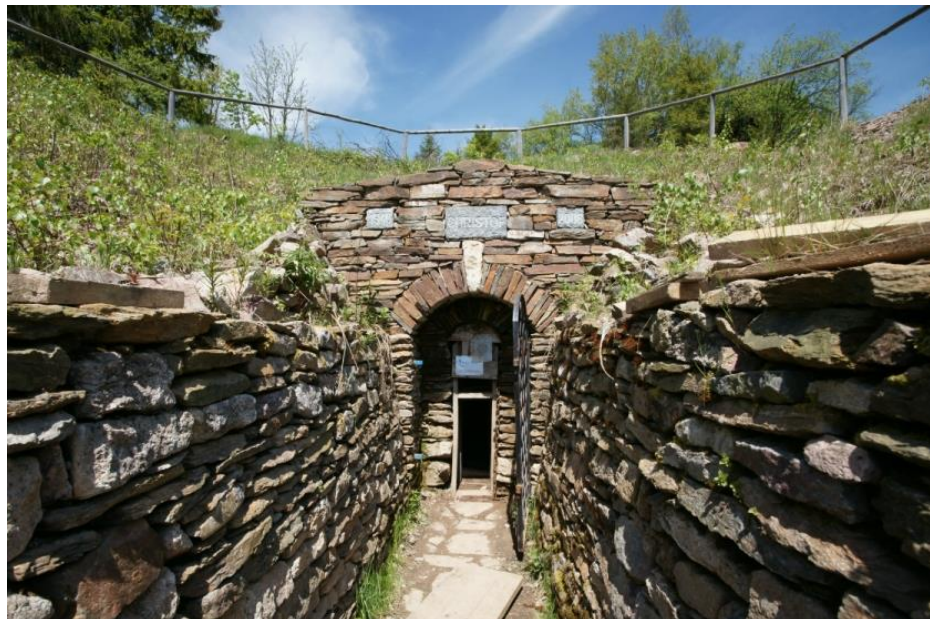
Zděný portál štoly Kryštof z roku 2008 (foto: J. Albrecht).
