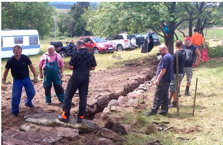
Členové Spolku přátel dolu sv. Mauritius při opravě příkopu v roce 2014.
