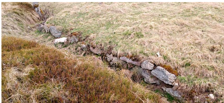
Starý vodní příkop poblíž „Maringotky“. Kamenné vyzdění je místy stále dobře patrné (foto: M. Urban).
