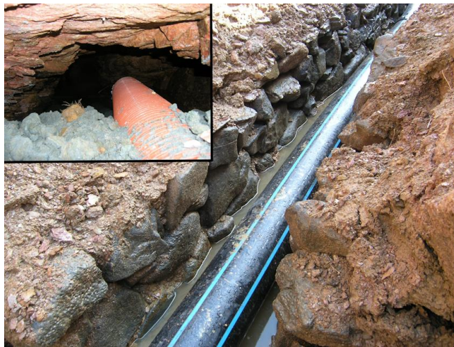
Čedičovými kameny vyzděné koryto příkopu v jeho počáteční partii na p.p.č. 1791, do nějž je dnes uloženo vodovodní potrubí, které vede až do staré štoly (foto z doby posilování vodovodu na Hřebečné v roce 2012: M. Urban).
