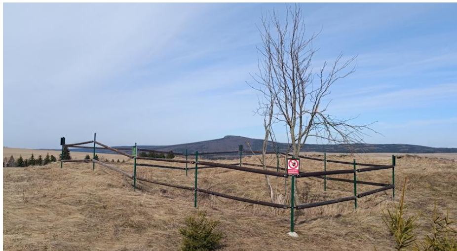
Kadaňská vodotěžná šachta v roce 2026 (foto: Michal Urban). Státní podnik Diamo v roce 2024 opravil oplocení a přidal nové výstražné a informační tabulky, avšak s chybnými údaji
